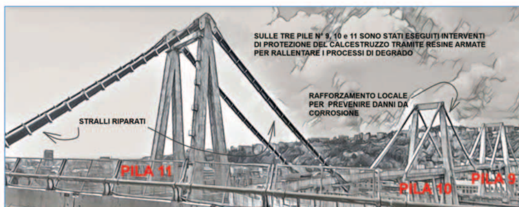
Figura 7. Intervento di risanamento strutturale del 1992: sostituzione strallo pila 11 e rafforzamento locale pila contigua.
