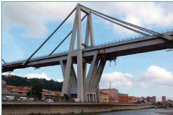
Figure. 2 e 3. Sistema bilanciato pila 9: foto prima del crollo e rendering schematico con indicazioni parti costituenti.
